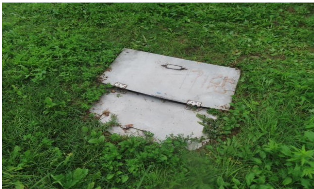
유량계실 덮개 상태양호
