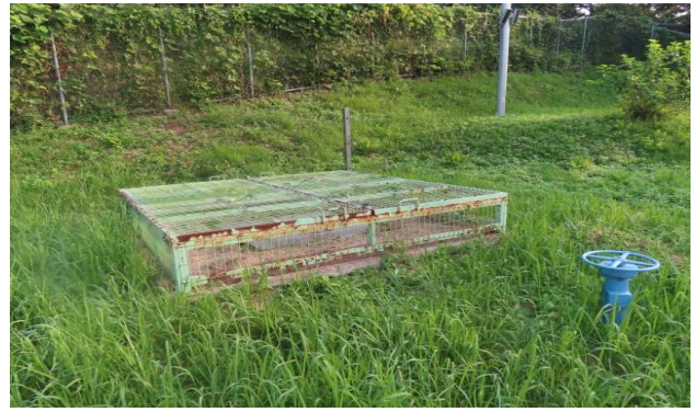
배수지 2지 덮개 상태양호
