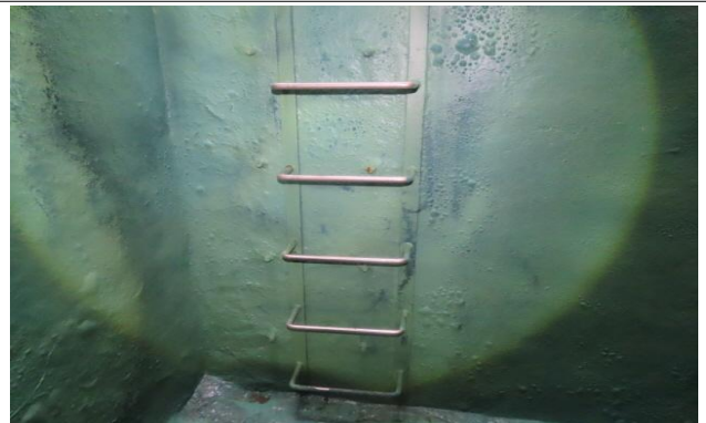
배수지 2지 진입사다리 상태양호
