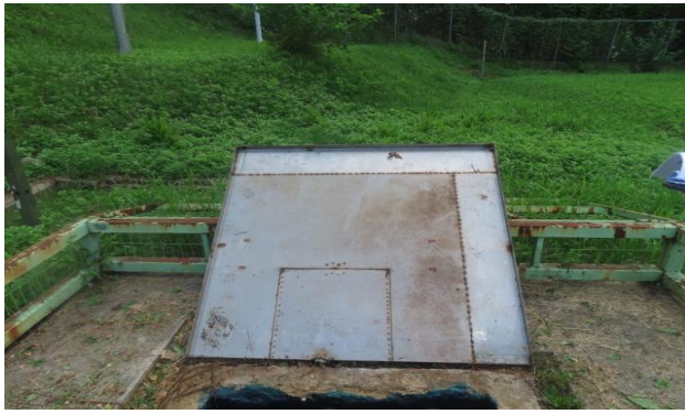
배수지 1지 덮개 상태양호
