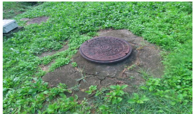
유입밸브실 덮개 상태양호
