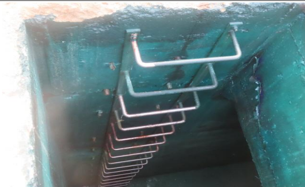
배수지 1지 진입사다리 상태양호
