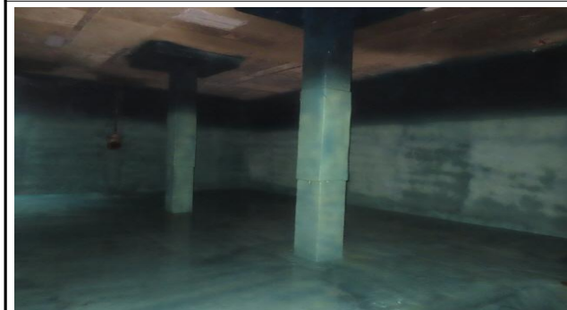
배수지 1지 내부 전경
